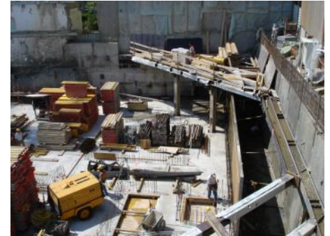
Stabilisation de l'enceinte de fouille
