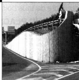
Murs de soutènement préfabriqués
