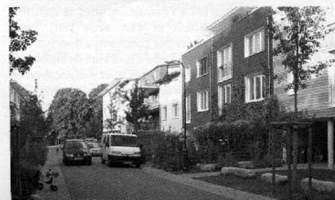
Quartier Vauban, Fribourg-en-Brigau densité 0.9
